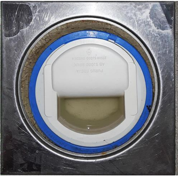
Våtrom - [Sluk bad]
