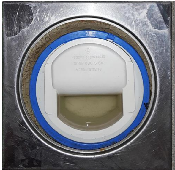
Våtrom - [Sluk bad]
