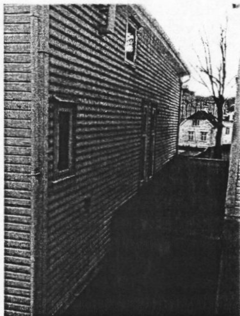
Bildet viser den aktuelle fasaden med rømningsvinduet øverst.
