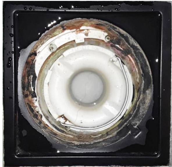
Våtrom - [Sluk bad]
