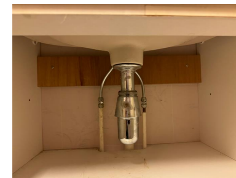
Rørøpplagg under servant.
