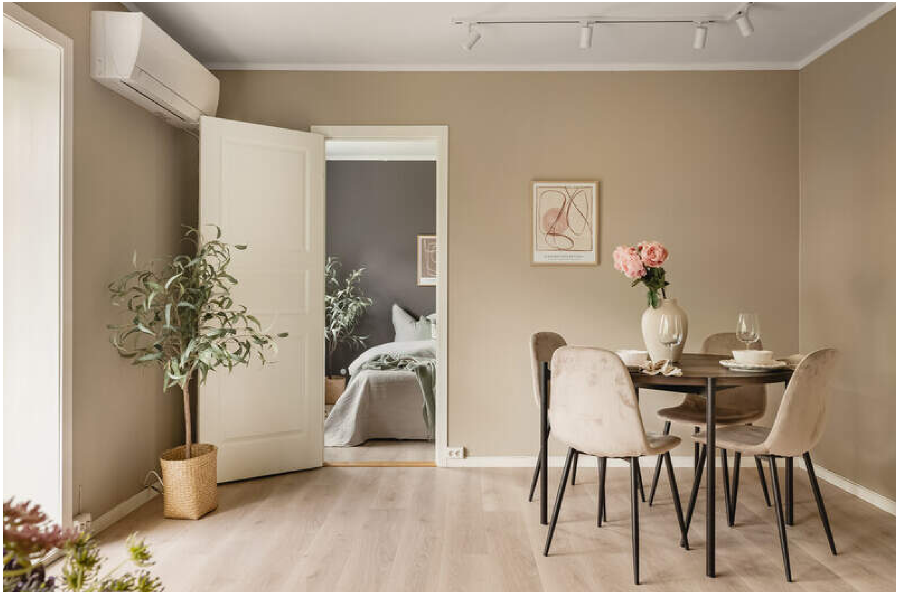
Det er lagt gipsplater på alle vegger for å få slette vegger, samt byttet lister på gulv og himling, og lagt nytt laminatgulv med isolasjon under. Varmepumpe i stuen (2019).
