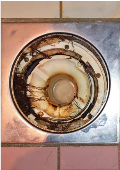
Våtrom - [Sluk bad]
