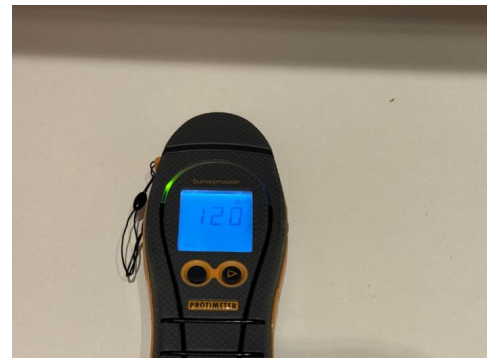
Ingen forhøyede fuktverdier ble registrert i kjøkkenbenken.
