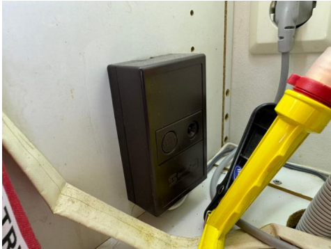
Lekkasjestopper fra byggeår.
