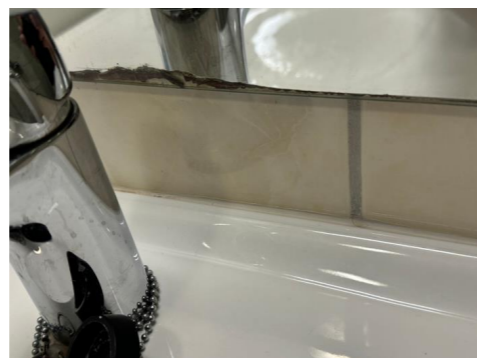
Rustgjennomslag i nedre del av speil.
