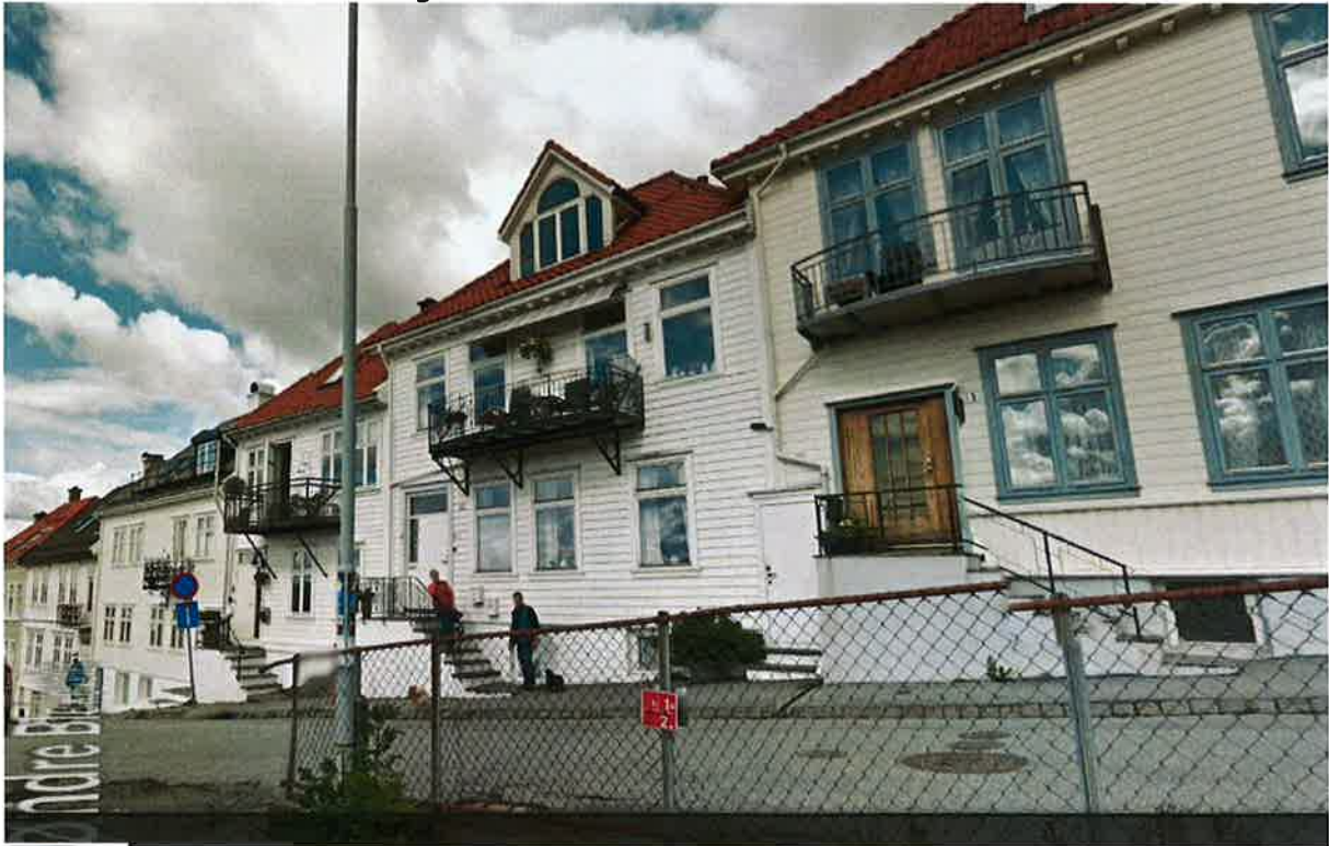
Øvre Blekeveien - Balkonger
