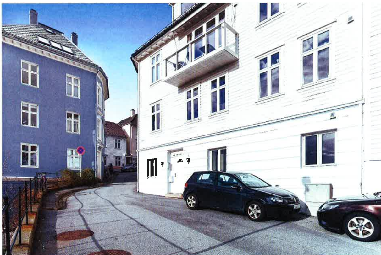
Fasade og skrå foto
