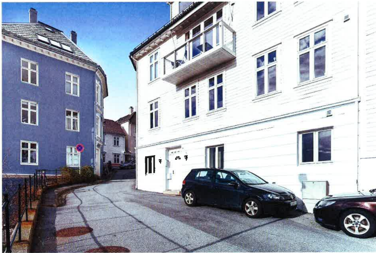
Fasade og skrå foto
