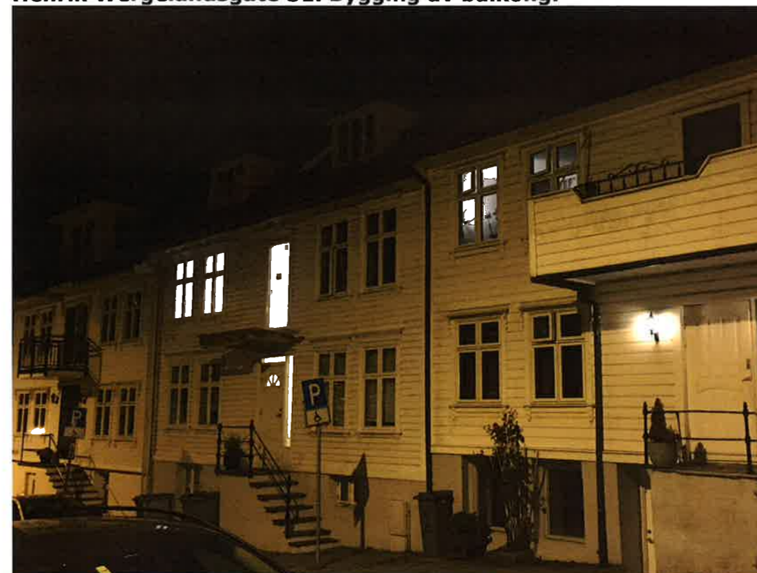
Vedlegg 6 Henrik Wergelandsgate 31. Bygging av balkong.
