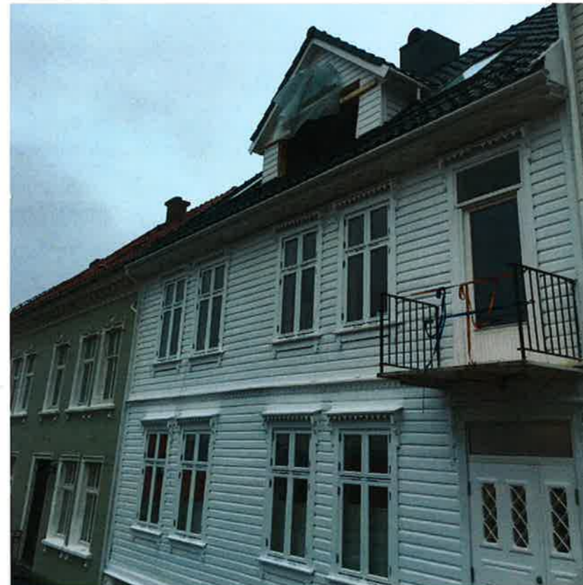
Vedlegg 4 Øvre Blekeveien 11. Bygging av takopplett og ny balkong. Saks nr. 201436138.
