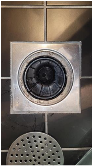
Våtrom - [Sluk bad]
