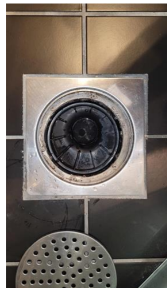
Våtrom - [Sluk bad]
